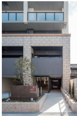
〈スロープ・手すり〉
