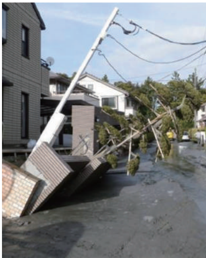
〈被災時の状況〉
